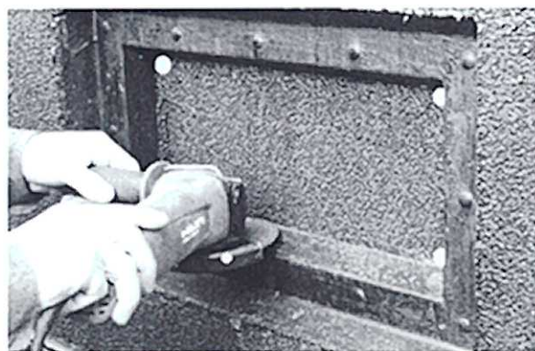
Fot. 7 Cięcie betonu szlifierką kątową
