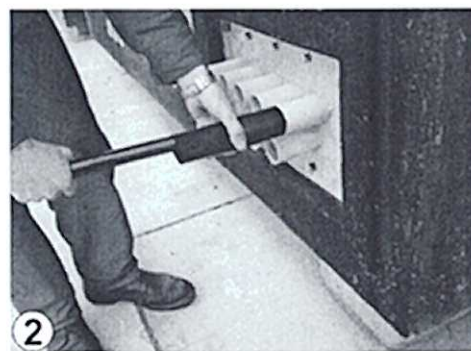
2 Po ułożeniu kabla w stacji, koszulkę termokurczliwą naciągamy na przepust.
