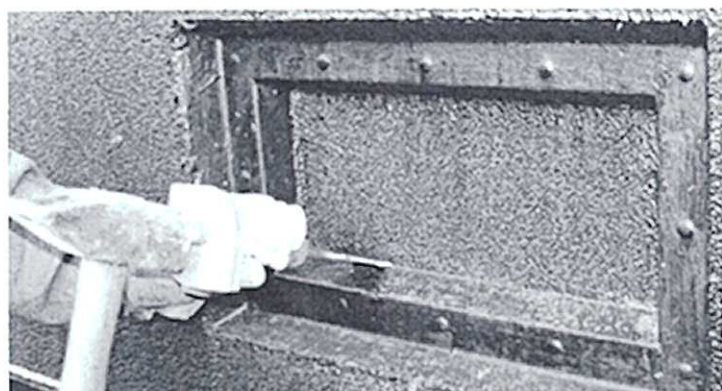
Fot. 10 Wybijanie otworu przecinakiem
