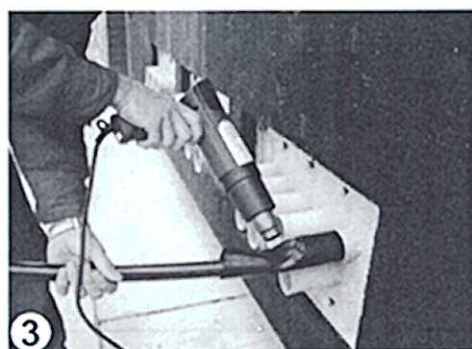
3 Koszulkę termokurczliwą zgrzewamy w ten sposób, aby po zastygnięciu szczelnie zacisnęła się na przepuscie i na kablu, tworząc w ten sposób szczelną izolację.
