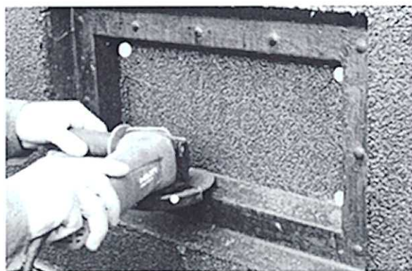
Fot. 7 Cięcie betonu szlifierką kątową
