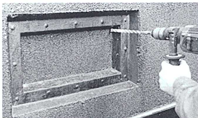
Fot. 5 Wiercenie otworów
