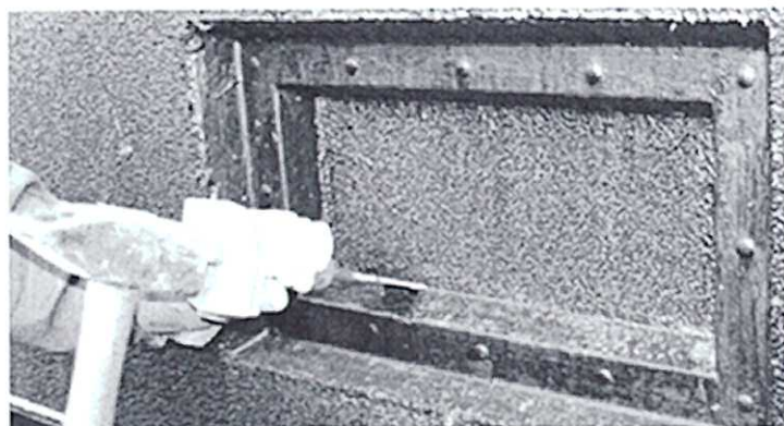
Fot. 10 Wybijanie otworu przecinakiem
