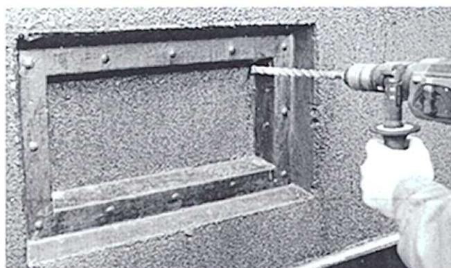
Fot. 5 Wiercenie otworów
